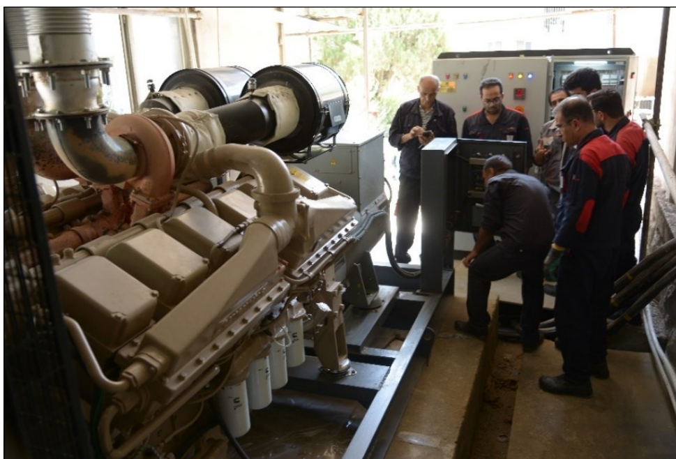
نصب ژنراتور جدید (کومنز ۱۱۰۰ وات) در سازمان زمین‌شناسی و اکتشافات معدنی کشور
